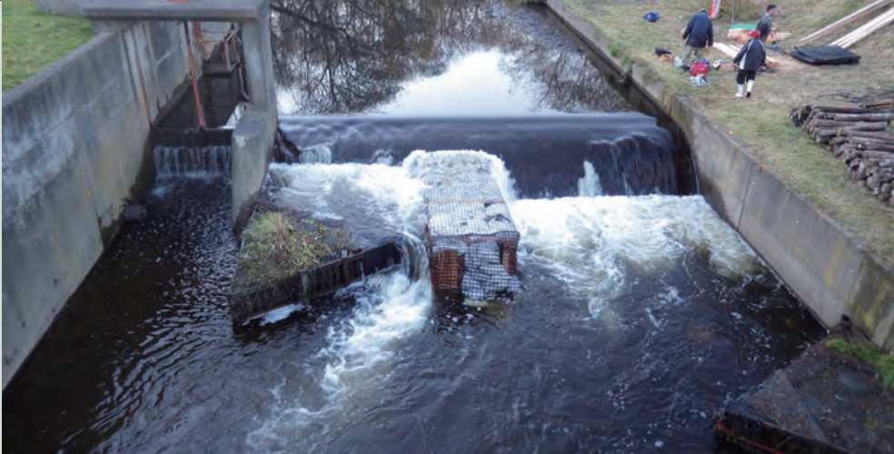
修復後の魚道。残った三角水制1基の横に四角い「過流堤」を据え、堰の3分の1ほどのプールを作った。2014年10月
