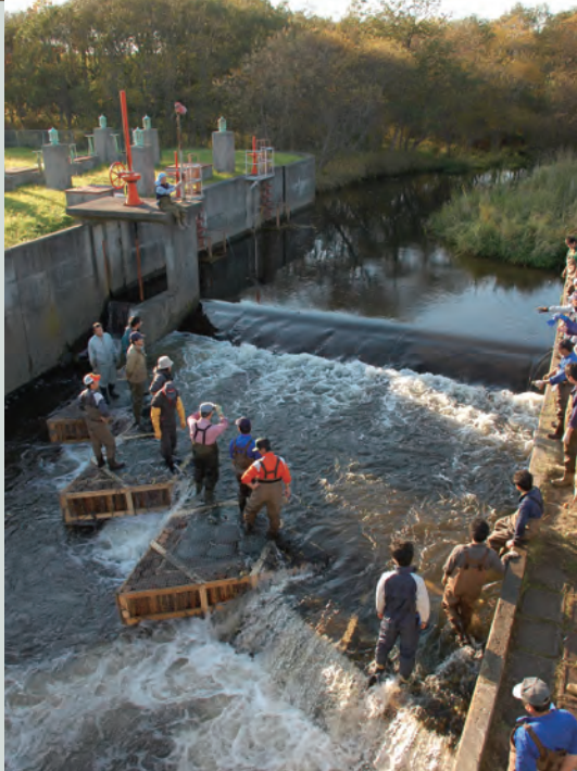
完成直後の魚道。当初は「三角水制」を4基配置して堰全面にプールを作った＝2008年10月
