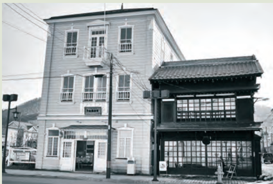
左 洋風木造3階建て 旧・堤商会 日魯漁業の前身（大正5年築・弁天町） 現・ロマンティコ ロマンティカ
